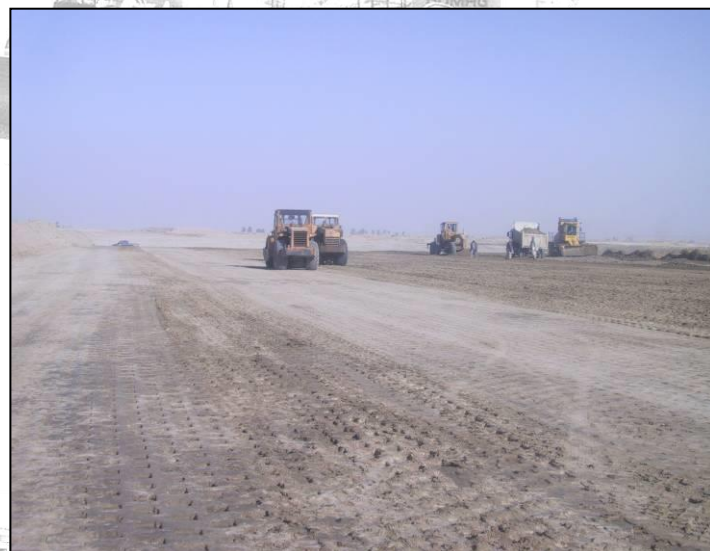
نمایی از عملیات اجرائی
