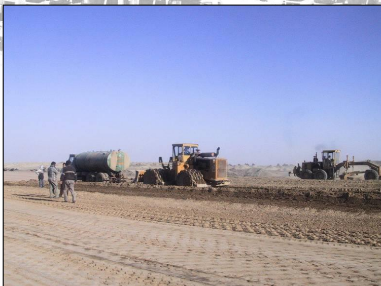
نمایی از عملیات اجرائی
